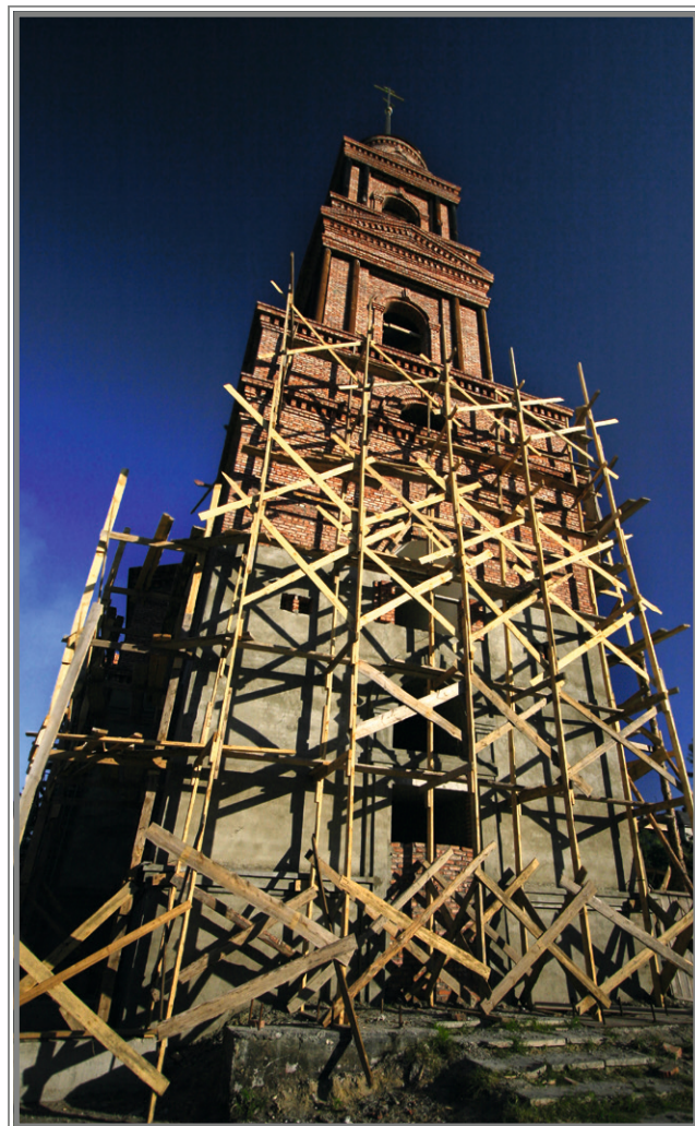
Соборная колокольня в строительных лесах. Август 2007 г.
