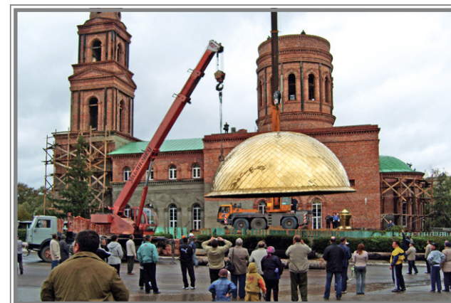
Установка купола и креста. Сентябрь 2007 г.
