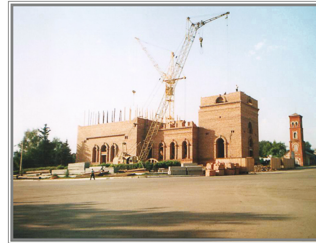
Возведение колокольни. 2006 г.
