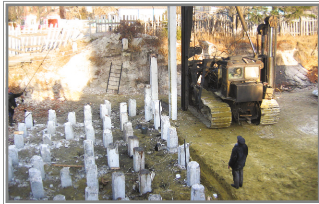
Начало строительства. 2005 г.
